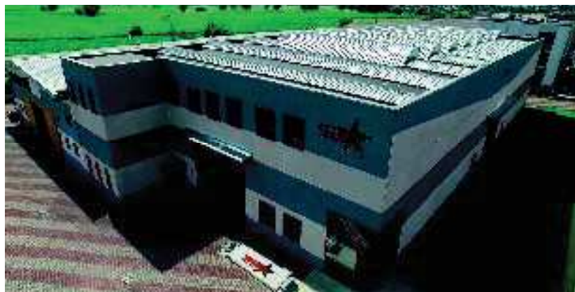
Vista della SPD sede via Leonardo da Vinci dove è presente il reparto macchine utensili e la direzione commerciale
