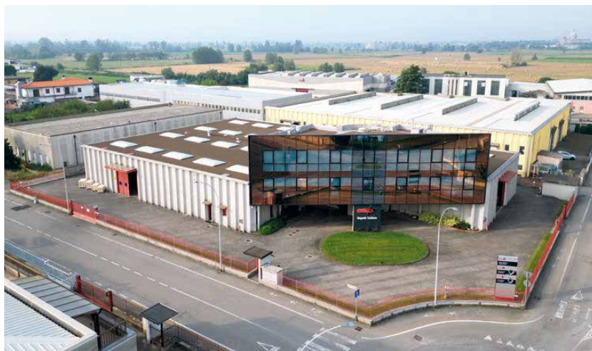
La sede di SPD a Caravaggio (BG) è il cuore logistico e amministrativo aziendale
